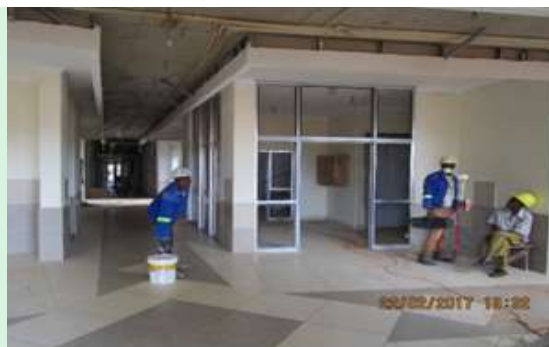
Figura 5: Pintura interior do edifício
