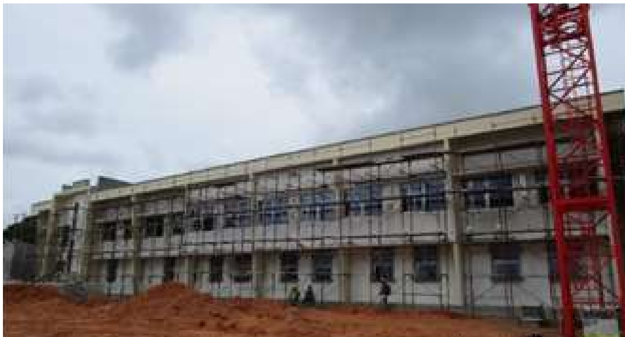
Figura 6: Parte exterior – fachada
