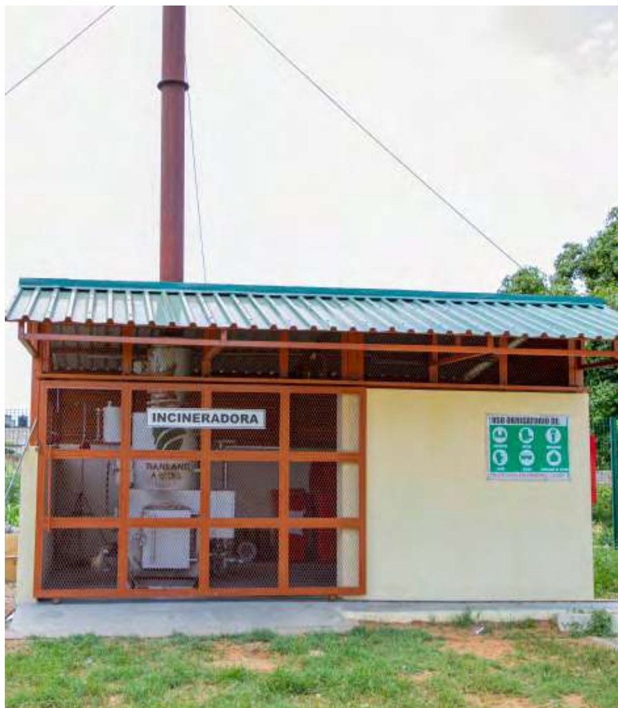
Figura 14: Incineradora de alta temperatura e câmara dupla com capacidade para alcançar entre 1100-1300°C, excelente desinfecção e esterilização altamente eficaz. Modelo instalado no campus do INS sede, em Marracuene.
